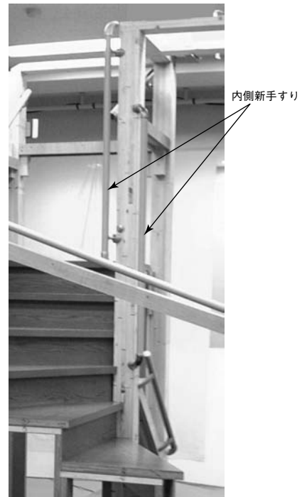
図4 内側新手すり
