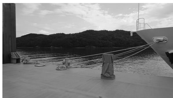
図2 陸上からの船首係留索の状態
