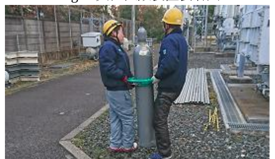
Fig3: 装置使用時のボンベ運搬作業
