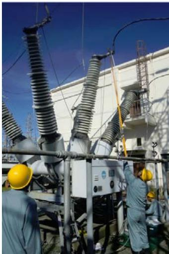
図1 アース線取扱い作業 (例:154kV 機器)
