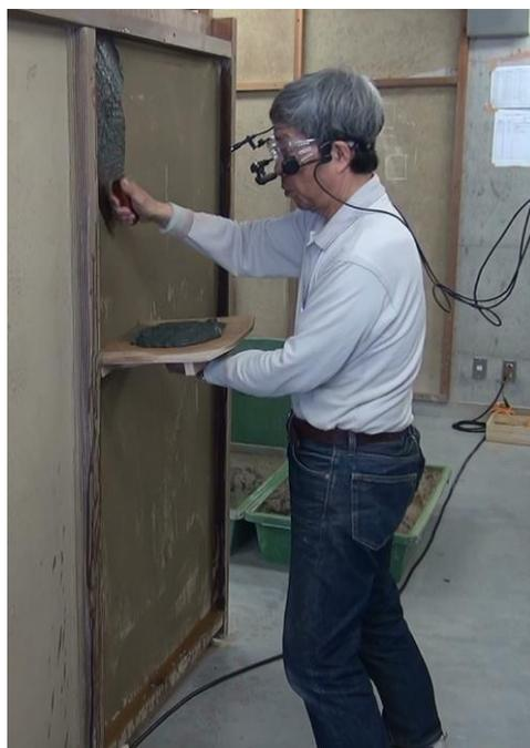
図1 中塗り工程の作業風景
